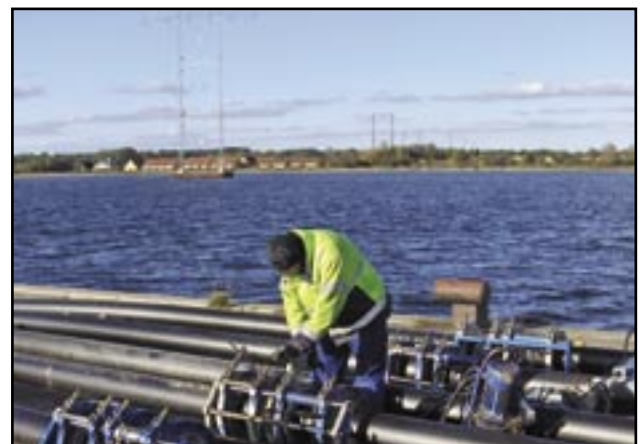
»Samlebåndssvejsning« på kajarealet. I baggrunden højspændingsmaster, som blev erstattet af den undersøiske kabelføring.
