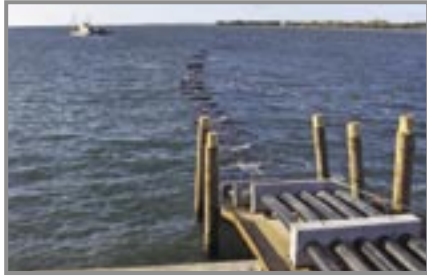
I takt med at rørene blev svejset sammen blev de ført ud i vandet. En slæbebåd holder styr på de lange rør.
