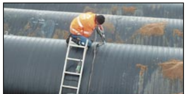
De enkelte røreheder á 18 meter blev svejset sammen til 36 meter lange ø 2400 mm rør.
